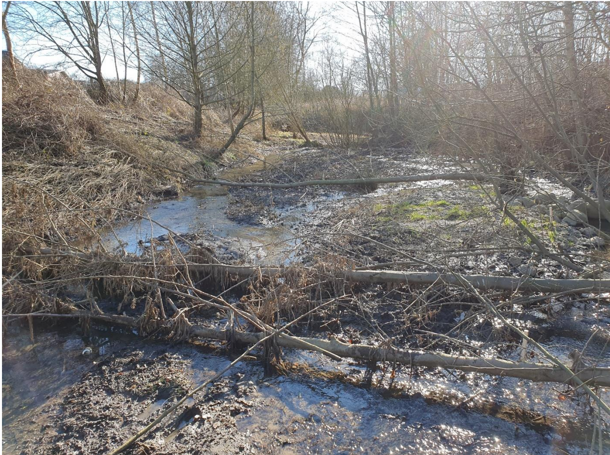
Figur 2: Vandløbet set i opstrøms retning gennem bassin B303. Som det ses står der ikke vand i bassinet, og det er under tilgroning med primært pil.
